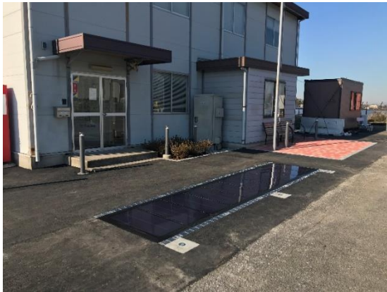
路面型太陽光発電パネル（日中）
