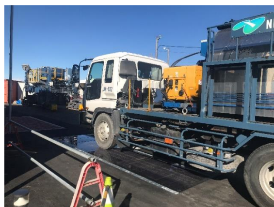
大型車両停車状況
