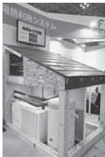
PV一体型樹脂屋根材と太陽熱利用ZEH化する
